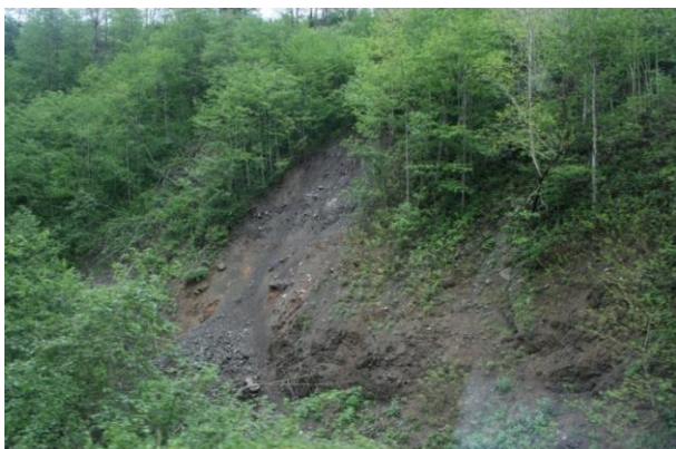
Fig. 2. Landslide in Büyükdere HEPP, Keşap, Giresun
